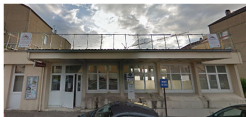
Salle des Nelmonts sanitaires et sas d'entrée
