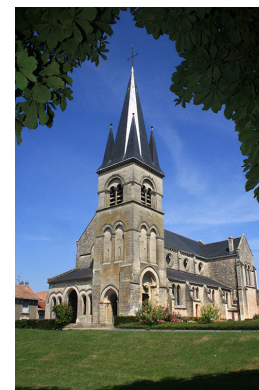
Eglise stationnement et cheminement PMR
