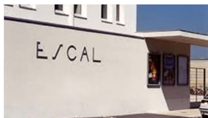
Escal sanitaires et dispositif pour malentendants et malvoyants dans la salle de spectacle
