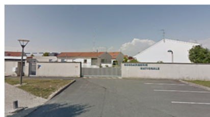
Gendarmerie accueil PMR et création d'un logement avec deux espaces de vie
