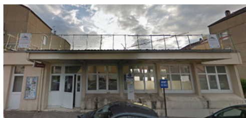
Salle des Nelmonts sanitaires et sas d'entrée
