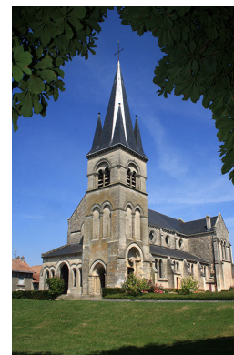
Eglise stationnement PMR
